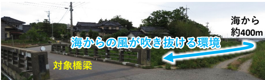
写真 1 対象橋梁の供用環境
