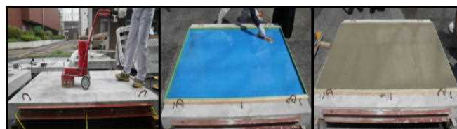
(1) 研掃 (2) 接着剤塗布 (3) 舗装 図-2 施工手順
