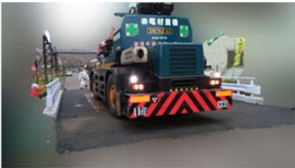
図-3 実橋载荷試験の状況
