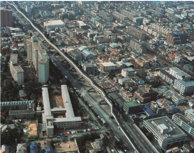
図-1 兵庫県南部地震での被災状況 （阪神高速 3 号神戸線）
