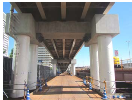
写真-3 高耐震性パイルベント橋脚
