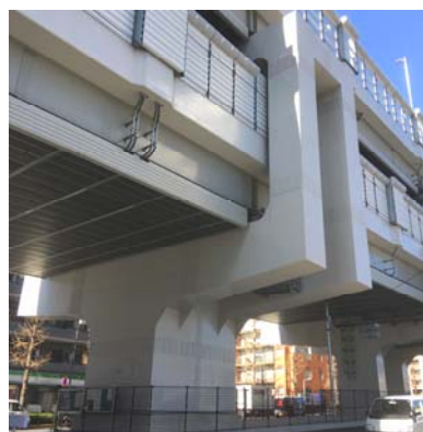
写真-2 ダブルラケット型橋脚
