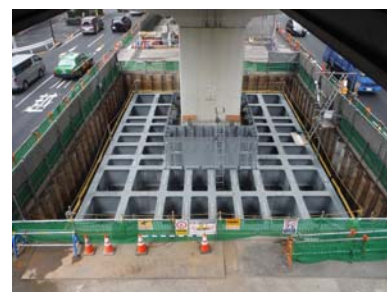
写真-1 鋼製格子部材の設置
