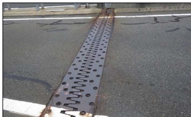
図-1 ダブルフェイス構造の伸縮装置
