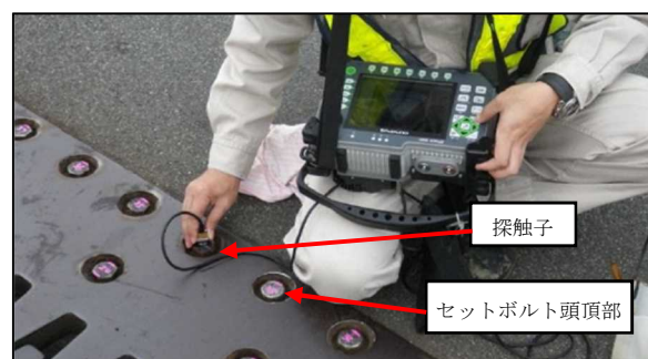
図-3 超音波探傷試験の様子
