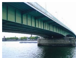
(b) 鋼橋(旧橋)側から
