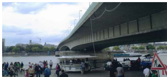
(a) コンクリート(新橋)側から
