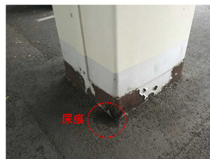
図 2 鋼板巻き RC 柱の地際部
