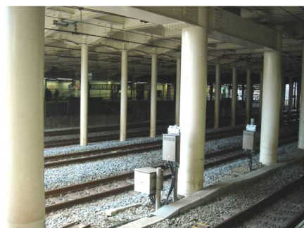
(b) 線路上空人工地盤
