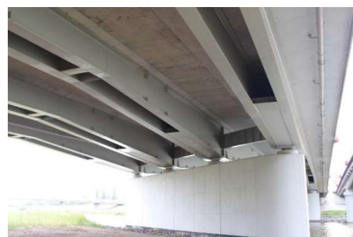
図-1 連続二重合成 I 桁橋
