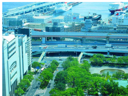
写真1. 税関前歩道橋（現況）
