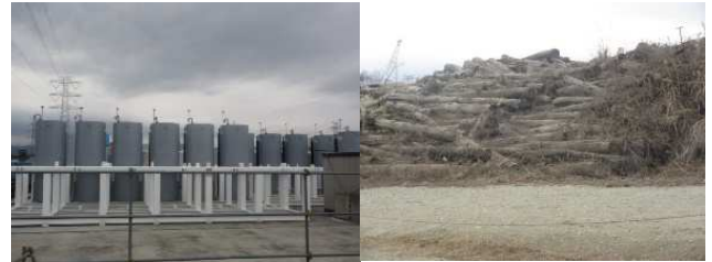
左：吸着塔の保管，右：伐採木の保管 図-1 福島第一原子力発電所内の廃棄物等の保管状況
