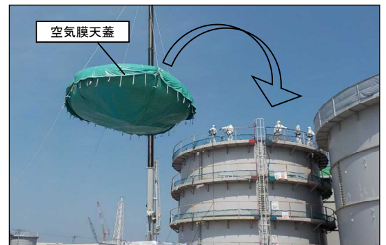
写真－1 仮設天板設置状況 (特許出願番号:2017-040568)
