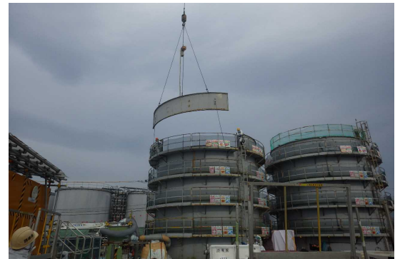
写真－2 タンク解体状況
