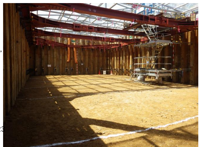
写真-2 汚染土壌回収完了状況（深層部）
