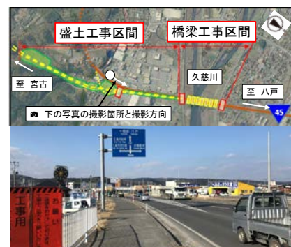
写真 1 施工現場の概要
