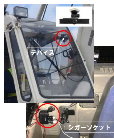
写真 2 センサ取付け状況
