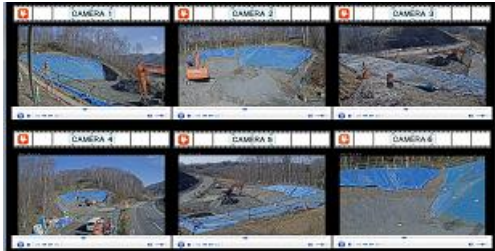
定点での施工状況比較
