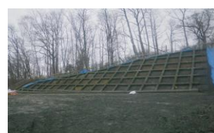
写真4 2018/1116/0842 法枠工 完了
