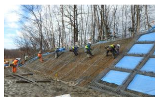
写真1 2018/1114/1100 法枠工 組立状況
