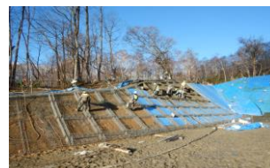
写真2 2018/1114/1403 法枠工 吹付状況
