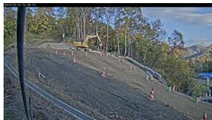
図7 側面からの掘削作業
