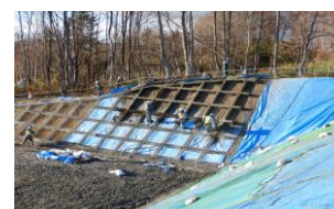
写真3 2018/1114/1416 法枠工 吹付状況
