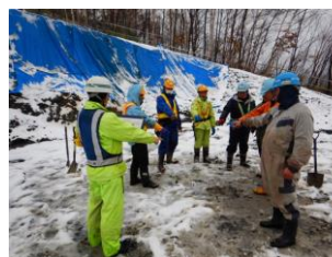
写真5 作業前安全点検
