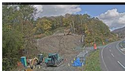
図8 下端部からの掘削運搬作業
