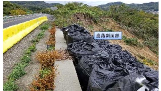
図-1 法面崩落箇所
