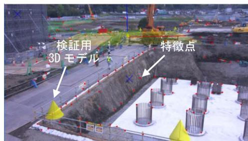
図-3 特徴点（赤点）と検証用 3D モデル
