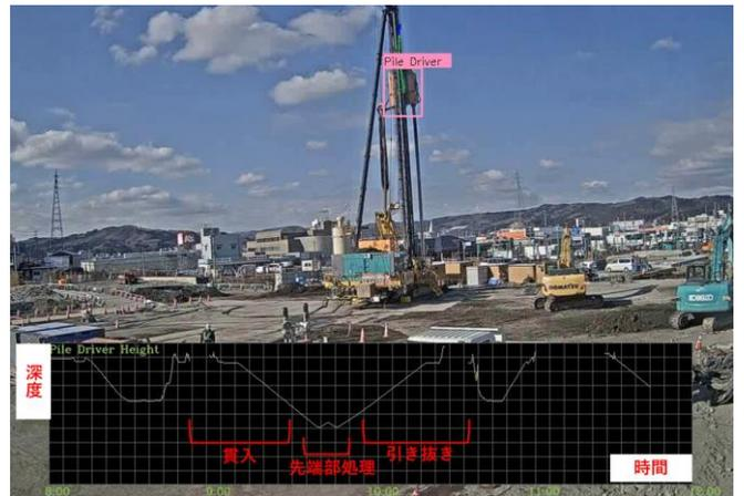
写真5 深層混合処理機の稼働解析 (攪拌モーターヘッドの位置から波形データ化)
