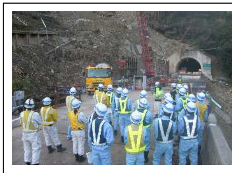
写真-6 若手のための若手による土砂崩落現地調査
