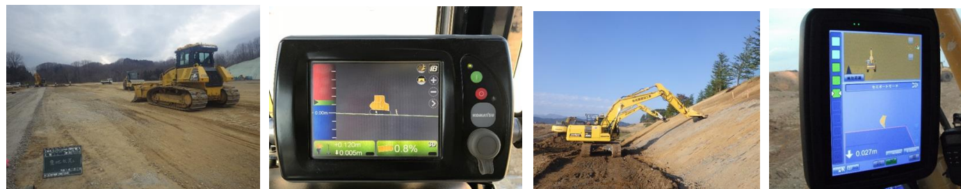
図-5 マシンコントロール重機による整地、整形
