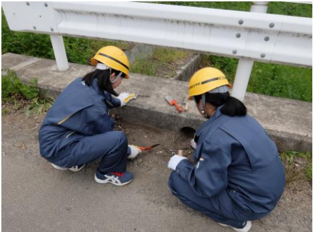
図-3 排水桝周辺の清掃
