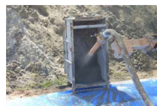
図-3 吹付け試験状況
