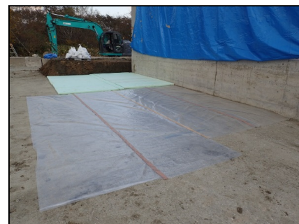
写真-3 ③気泡緩衝材の設置状況
