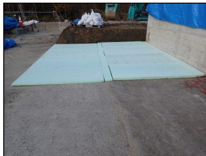
写真-2 ②断熱マットの設置状況
