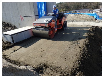
写真-1 ①客土の設置状況
