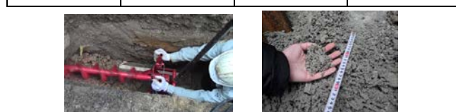
図 3 オーガによる予備切削試験
