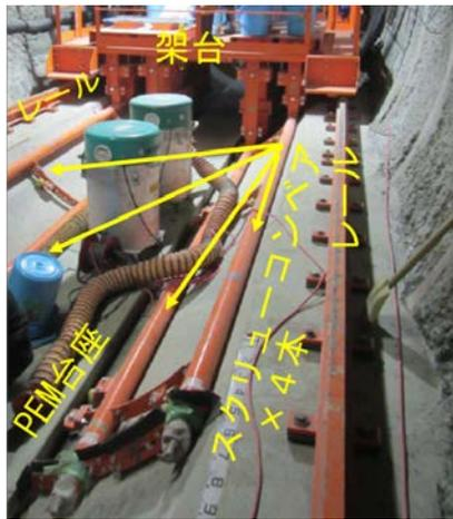
図-4 ペレット充填装置
