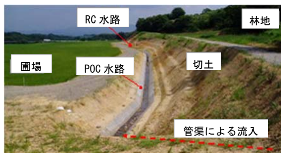
写真－1 胆沢区 POC 水路圃場整備後の状況 1)
