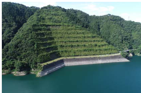
写真1 宮ヶ瀬湖と法面緑化（2018年7月）
