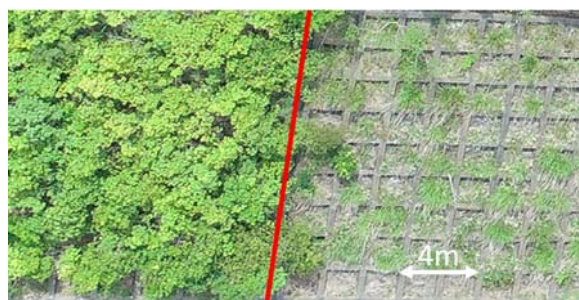
写真2 当該法面部分（左）と草本類種子吹付けによる法面部分（右）（2018年7月）
