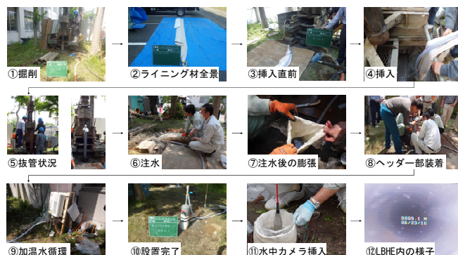
図-2 施工試験の様子
