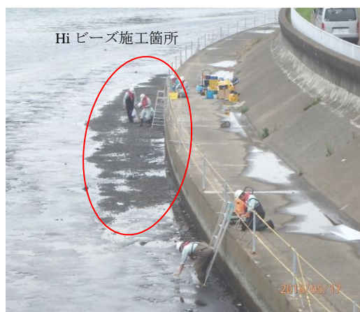
写真-2 Hi ビーズ施工箇所状況
