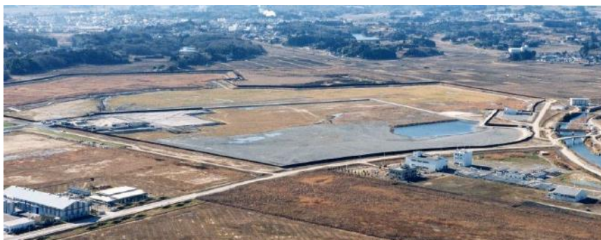
写真-1 石炭灰埋立て前の処分場整備状況
