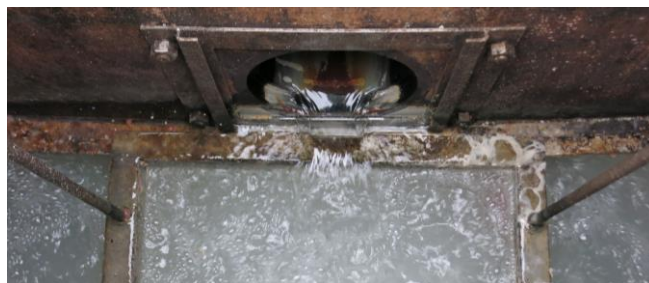
図 1 SA グリストラップの流入部の写真
