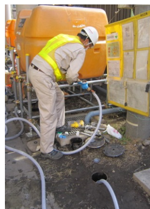
写真-1 現場試験状況
