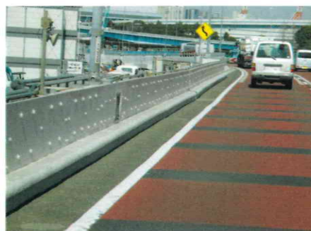
写真 - 5 施工後の状況
