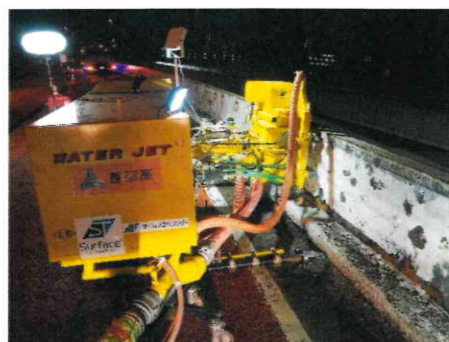
写真 - 3 ミストジェット施工状況
