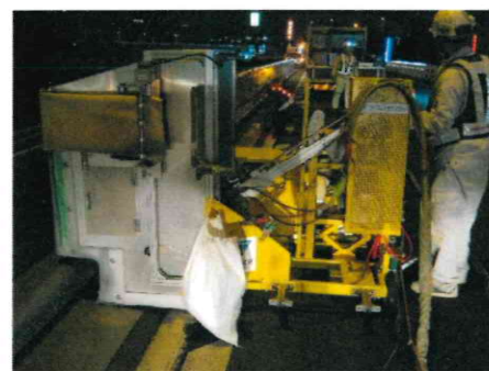
写真 - 4 自動塗装施工状況
