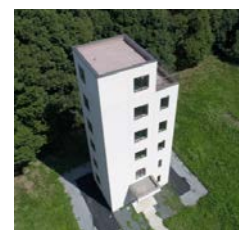
写真1 ツーバイフォー6階建て実大実験棟
