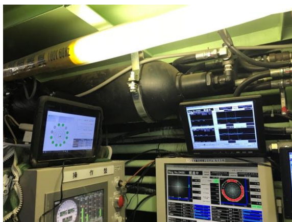
図-3 シールド坑内設置状況
