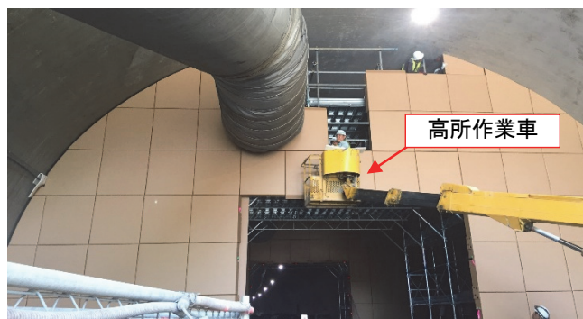
図-4 クレーン不要、高所作業車のみで設置
