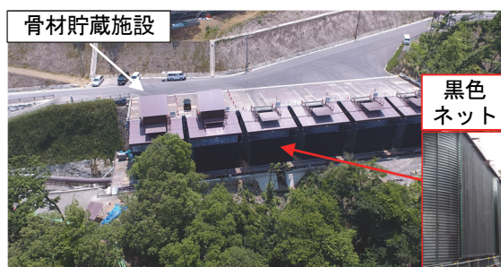
写真-2 黒色ネットによる骨材温度上昇防止対策
