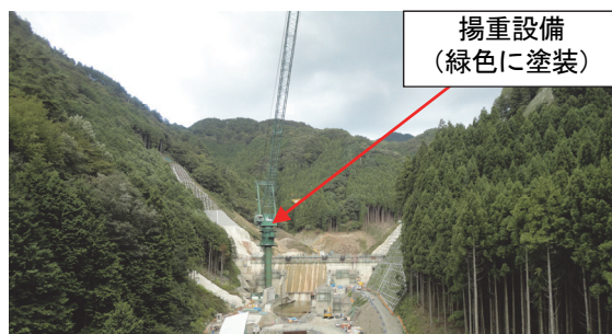
写真-1 アースカラーに塗装された揚重設備
