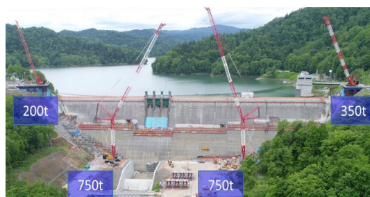
写真-1 打設用クローラクレーン配置状況
