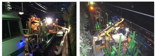
写真-3 リフトアップ台車での施工
