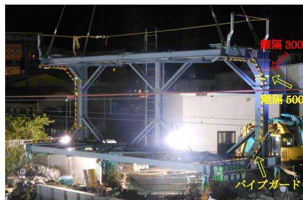
写真－2 コの字天秤印付け
