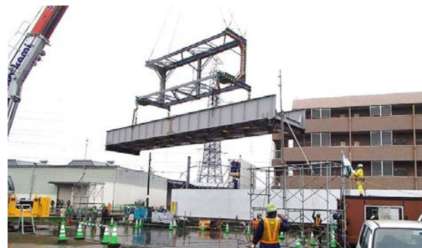
写真-3 試験吊り状況
