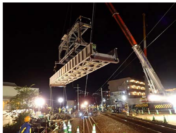
写真-4 工事桁架設状況
