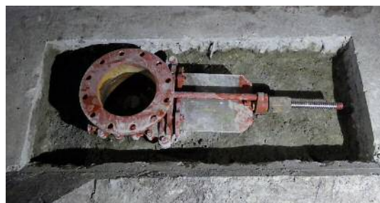
写真-3 シャッターバルブの設置状況 (軌道内, 下床版上)
