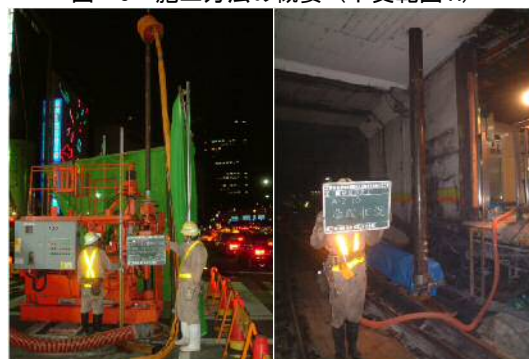
写真-1 貫通施工の状況
