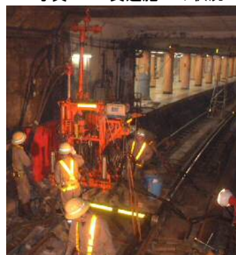
写真-2 構内施工の状況
