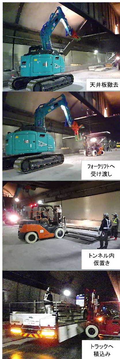
図3 天井板撤去作業サイクル
