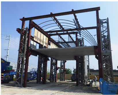
写真1 模擬トンネル試験ヤード
