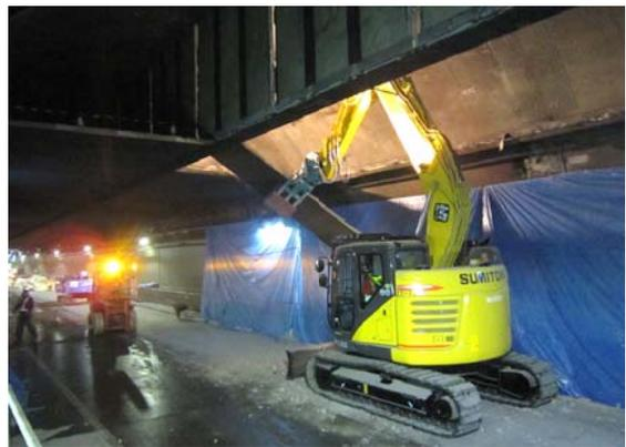
写真-2 天井板撤去状況
