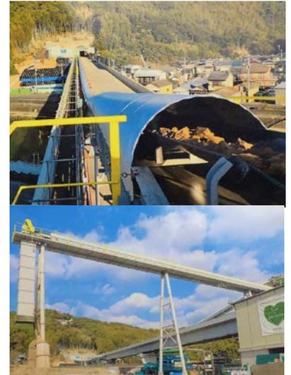
写真-3 トンネルズリ運搬ベルトコンベア設備状況
