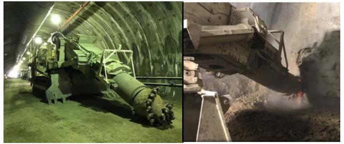
写真-2 機械掘削機（300kw 級）と掘削状況
