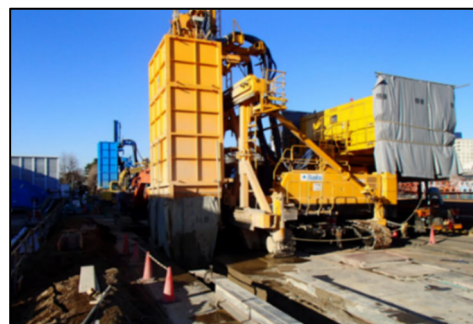
図-7 掘削状況（軟弱地盤上での作業）
