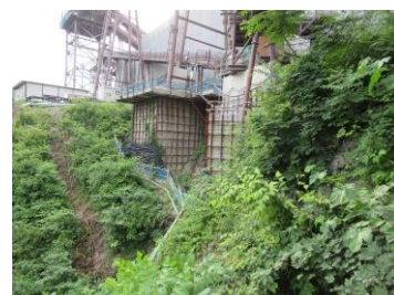
図-2 施工前状況
