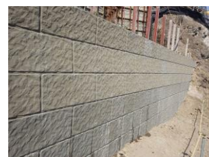
図-9 石積状埋設型枠
