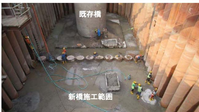
写真-4 ドライアップ施工状況
