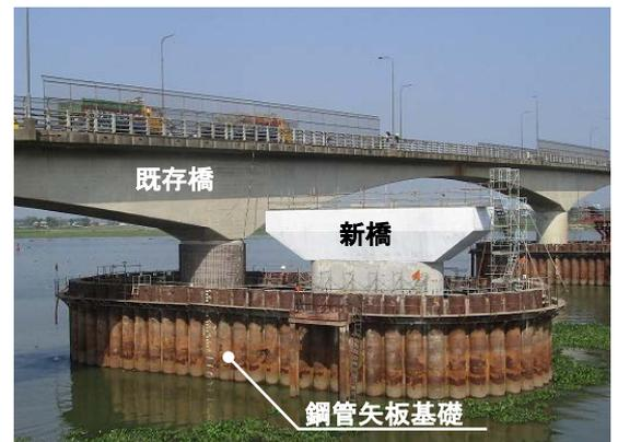
写真-1 鋼管矢板基礎施工状況
