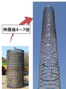
図-1 スtrand場所打ち杭工法で用いる鉄筋かご
