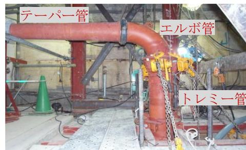
図-4 エルボ管とトレミー管の接続
