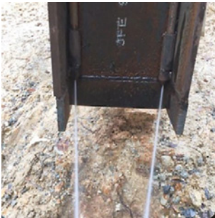
図-1 ガンパイル工法の主要な技術
